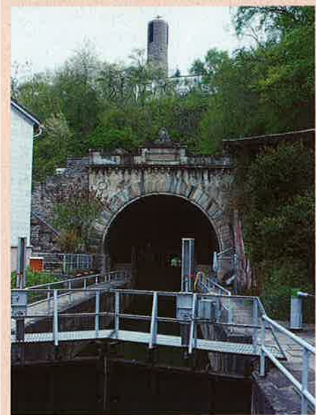
Einmalig in Deutschland: der Weilburger Schiffstunnel. 1847 wurde der Tunnel unter dem Schloßberg gebaut, damit mit Eisenerz beladene Schiffe an Weilburg vorbeischieppern konnten.
